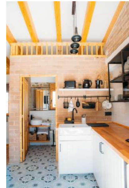
División interior realizada con Bloques de Tierra Comprimida
