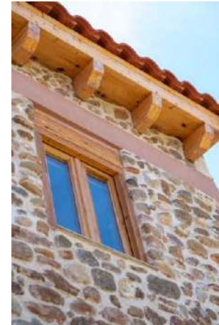
Fachada de piedra con mortero de cal
