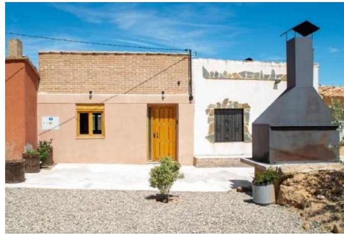
Fachada sur hecha con Bloques de Tierra Comprimida
